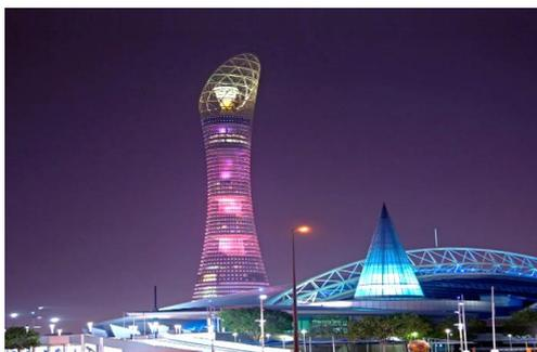
brennende Fackel hält. Das Tragwerk des Aspire Tower besteht aus einem zylindrischen Betonkern, der von einem Stahlgewebe umhüllt ist, sowie aus einer energieeffizienten Glasfassade. Mit einer Höhe von 300 Metern ist es das höchste Bauwerk Qatars. Innerhalb der Aspire Zone – einem multifunktionalen Sport-, Unterhaltungs- und Einkaufszentrum –
